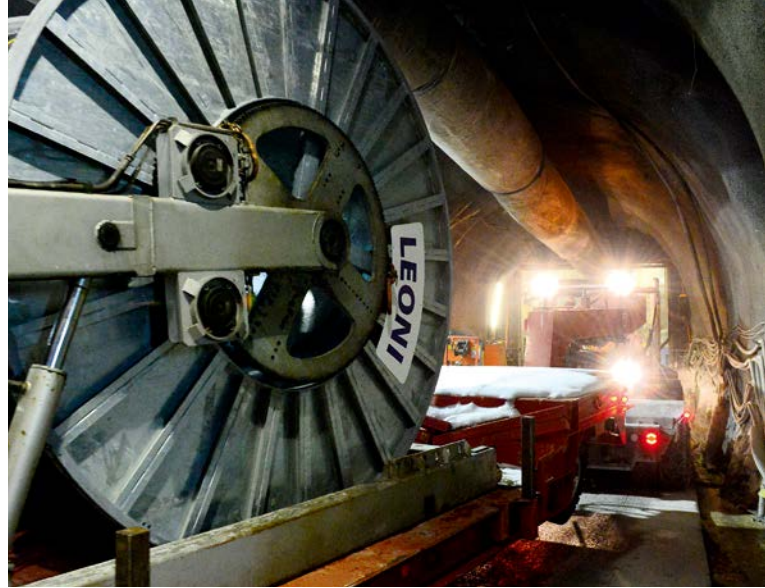
Millimetergenauer Transport der Kabelspule und Kabelzugmaschine im Berg.
